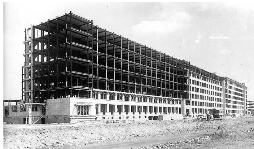
Figuur T-R 38: UZ in aanbouw.
