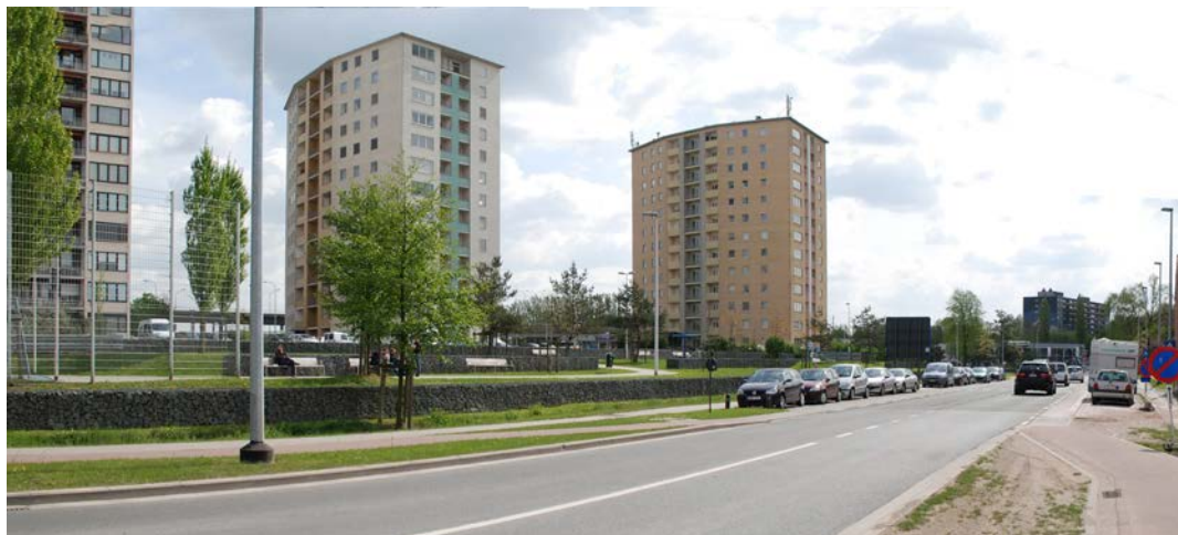
Figuur T-R 86: Nieuw aangelegde E3-plein.
