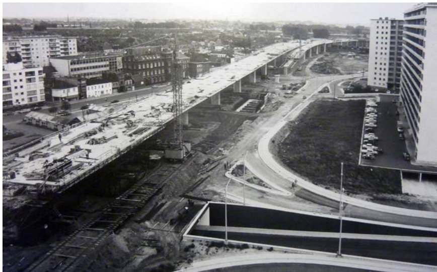
Figuur T-R 12: Aanleg van het viaduct. (Bron: Stadsarchief Gent 'Zwarte Doos', reeks GAGB, volgnr. 462.)
