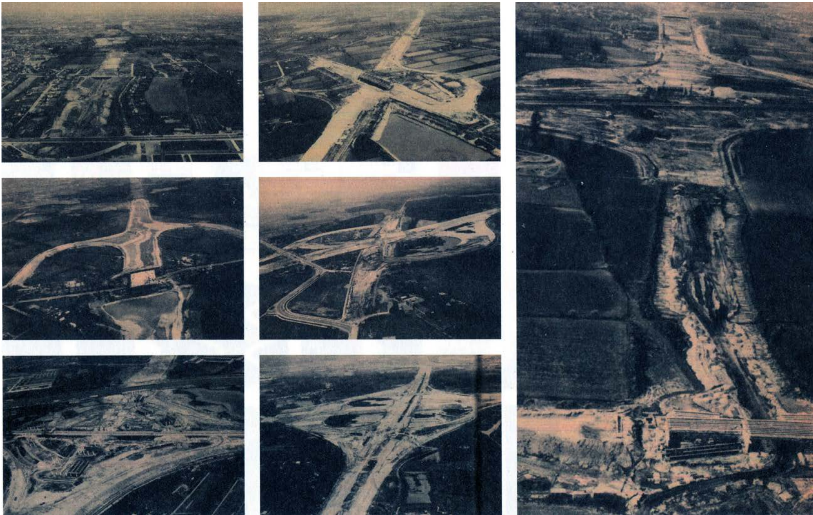
Figuur 29: luchtfoto's van de aanleg E3. (bron: Zie-magazine, 6 jaar E3 intercommunale , fotoreeks, 28 mei 1969.)
