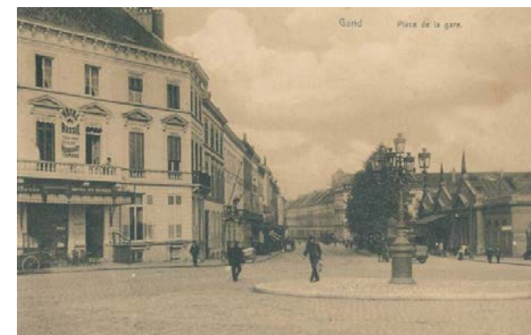
Figuur T-R 35: Zuidstationplein.
