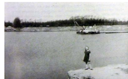
Figuur K-P 13: Aanleg verkeerswisselaar Destelbergen. (Bron: DE MANDEL, Le carnet du dizeau. E3 , tweemaandelijks tijdschrift, jaargang 11, nr. 4, Hulplau, Gent, juli 1968.)
