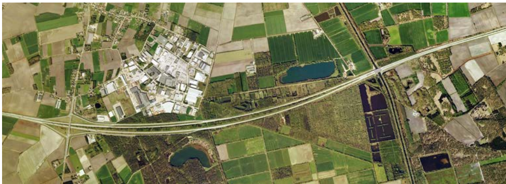
Figuur 32: E3 secties in de Kempen. Verbreding van de middenberm. (Bron: Google Earth®)
