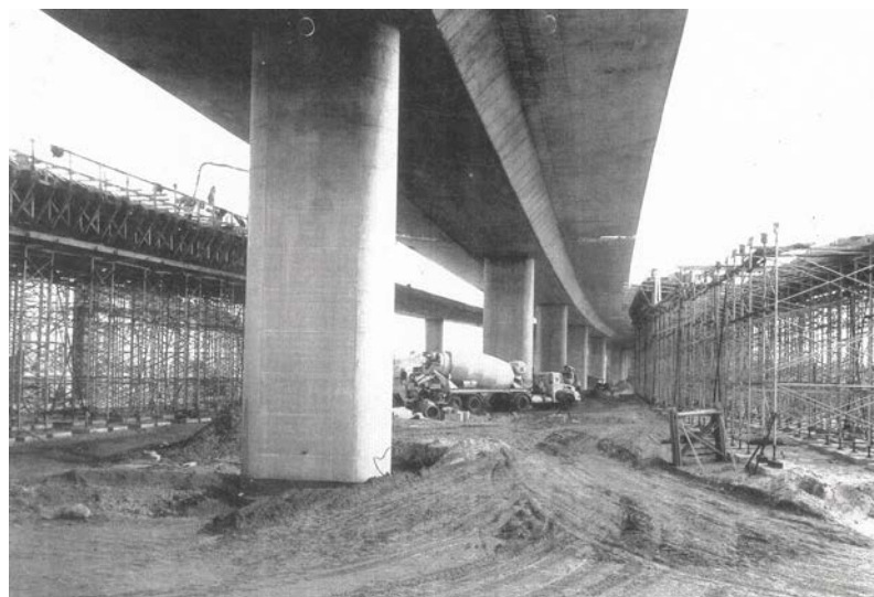
Figuur T-R 17: Viaduct Gent-Centrum. (Bron: Intercommunale Vereniging voor de Autoweg E3, E3 Jaarverslag 1971 , Govaerts, Deurne, 1972.)
