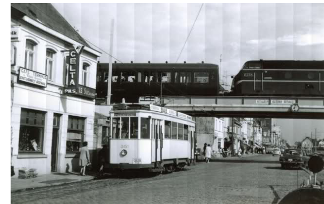
Figuur T-D 28: Ringspoorviaduct in gebruik, 1971.
