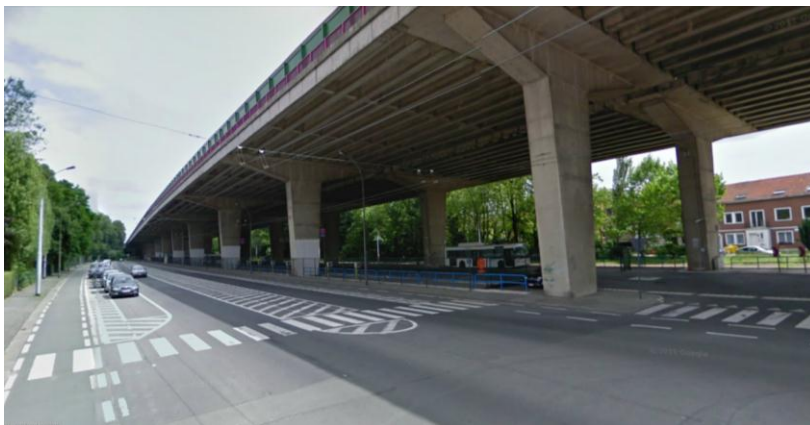
Figuur 75: Zicht op het viaduct vanuit de Jozef Wautersstraat (Foto: Google Street view, 1 december 2011)
