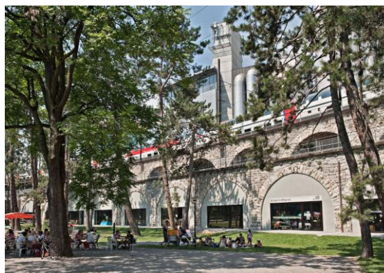
Figuur 83: Im Viadukt, Zürich (Foto: Ralph Hut, 2011)
